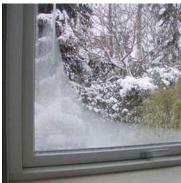
6. ábra: Az ablakon lévő vízcsapódás gyakran a lakások rossz szellőzésének a jele; Jobbra: A rhinitis előfordulási gyakorisága és esélyhányadosa a gyermekek körében, illetve páralecsapódás a hálószoba ablaktábláján [11]
